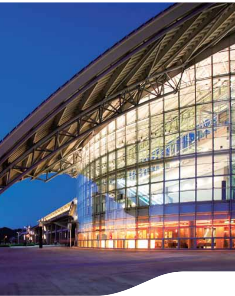
新竹站 Hsinchu Station
